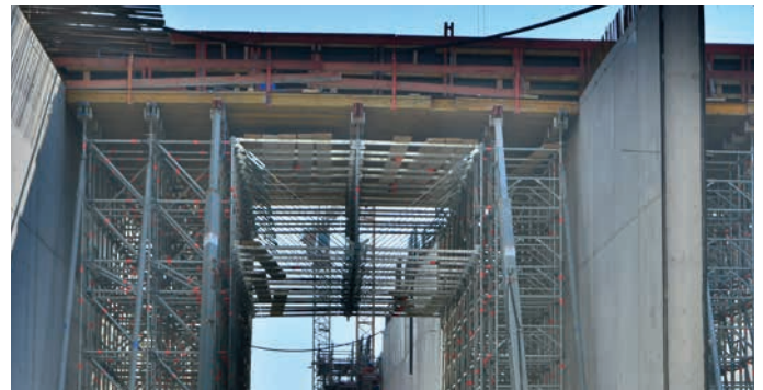
Überbrückung / Durchfahrtsöffnung im Traggerüst mit dem Allround Fachwerkträger.
